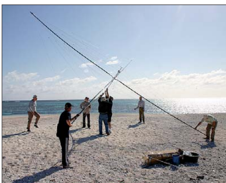
Aufrichten eines Dreielement-Spiderbeams
